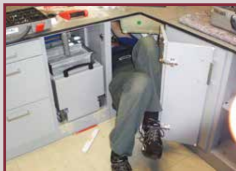
Endinstallation vor Ort
