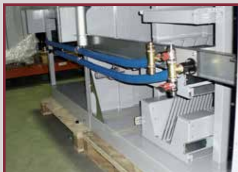
Vorinstallation im Werk
